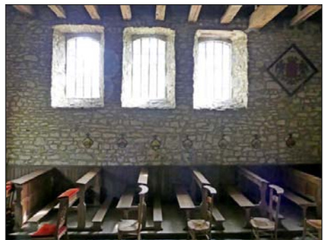
Baies, romanes à l'origine, agrandies au XVIII e siècle.
