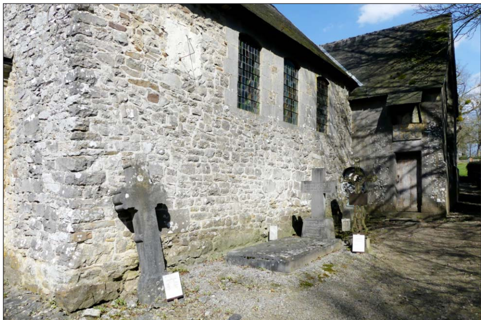
La chapelle, des croix rustiques, son cadran solaire, les trois baies et la porte d'entrée de la chapelle/tribune.
