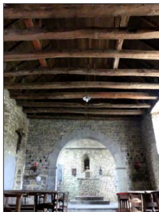
Les entrails de la charpente.
